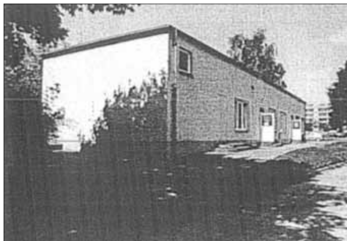
Ansicht des auf dem Grundstück befindlichen Gebäudes
